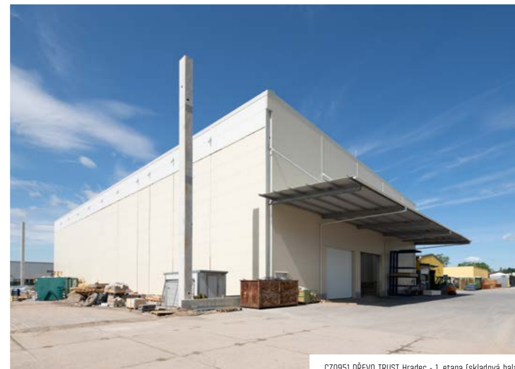
CZ0951 DŘEVO TRUST Hradec - 1. etapa (skladová hala)
